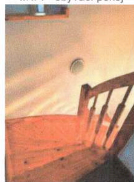
podkr. - schody z I.NP.
