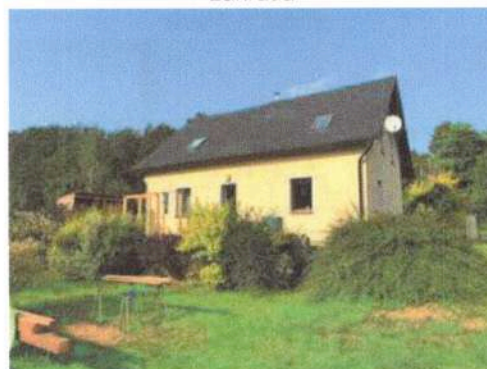
pohled od jihu
