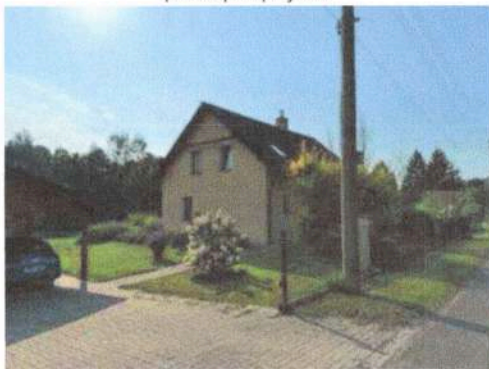
pohled od východu
