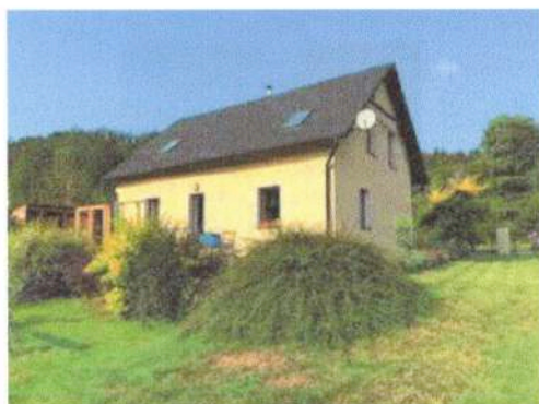
pohled od jihu
